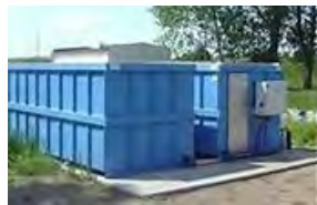
Kanalschachtbiofilter
