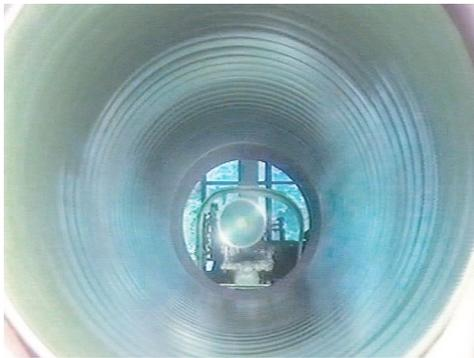
Beurteilung von organischen Beschichtungen im Kontakt mit Trinkwasser sowie die Anforderungen des DVGW-Arbeitsblattes W 270. Zudem widersteht die PUR-Auskleidung dauerhaft unterschiedlichen chemischen und mechanischen Belastungen (z.B. weichen, sauren oder salzreichen Wässern, Geschiebe im Abwasser oder Hochdruckreinigung) und gewährleistet die Beständigkeit gegen Abwässer aller Art.
